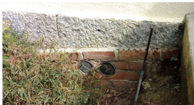
Figura 7 - Aberturas de ventilación finalizadas con rejillas
