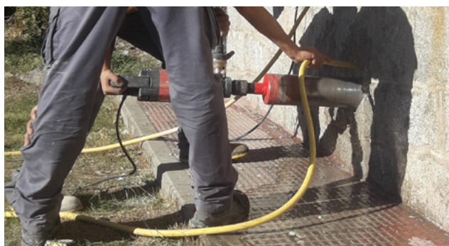
▼ Figura 7 - Perforación en la fachada para la salida del conducto de extracción
