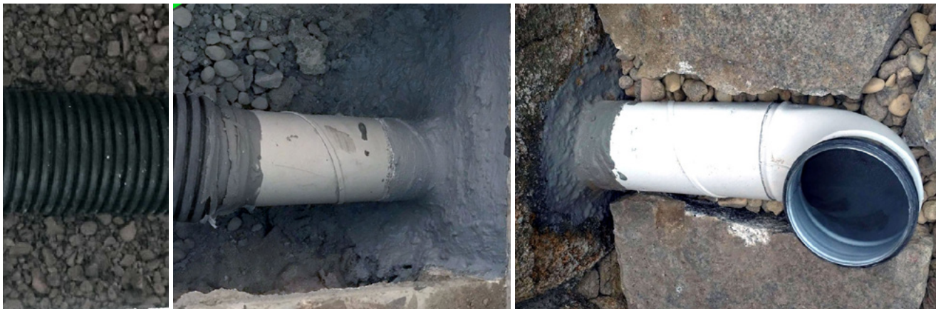
Figura 6 - Instalación de la capa de grava, el tubo perforado y el tubo pasamuros
