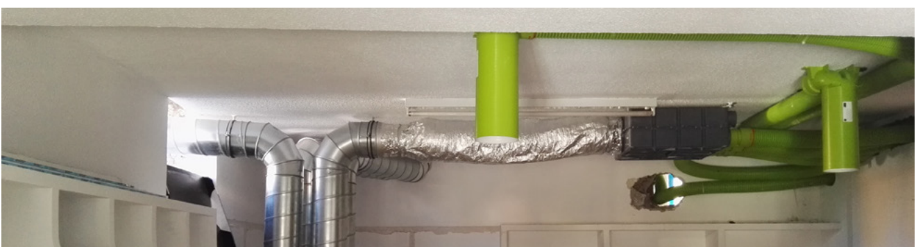
Figura 8 - Red de conductos de impulsión y expulsión
