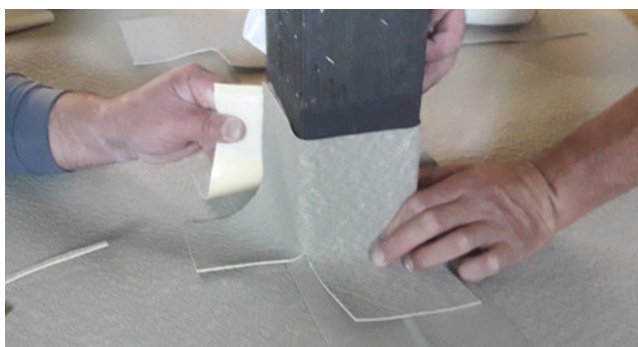
Figura 11 - Sellado del encuentro de la lámina con un pilar
