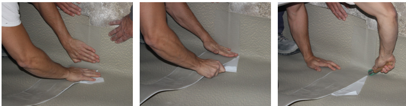
Figura 10 - Sellado del solape entre dos láminas
